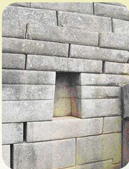
Aparejo Fino. Cámara de los Ornamentos, recinto adosado al Templo Principal.
